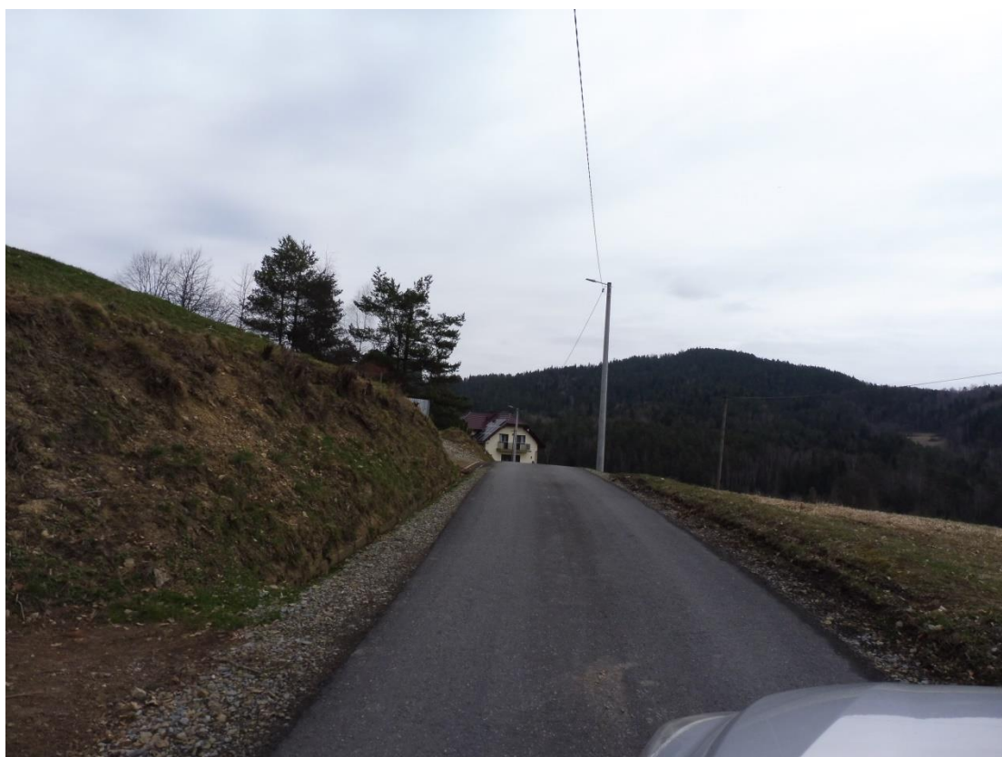
VIII. Remont ciągu komunikacyjnego i drogi ewakuacyjnej w Warsztacie Terapii Zajęciowej w Kukowie
