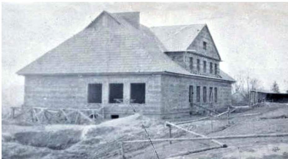
BUDYNEK SZKOLNY W STANIE SUROWYM
