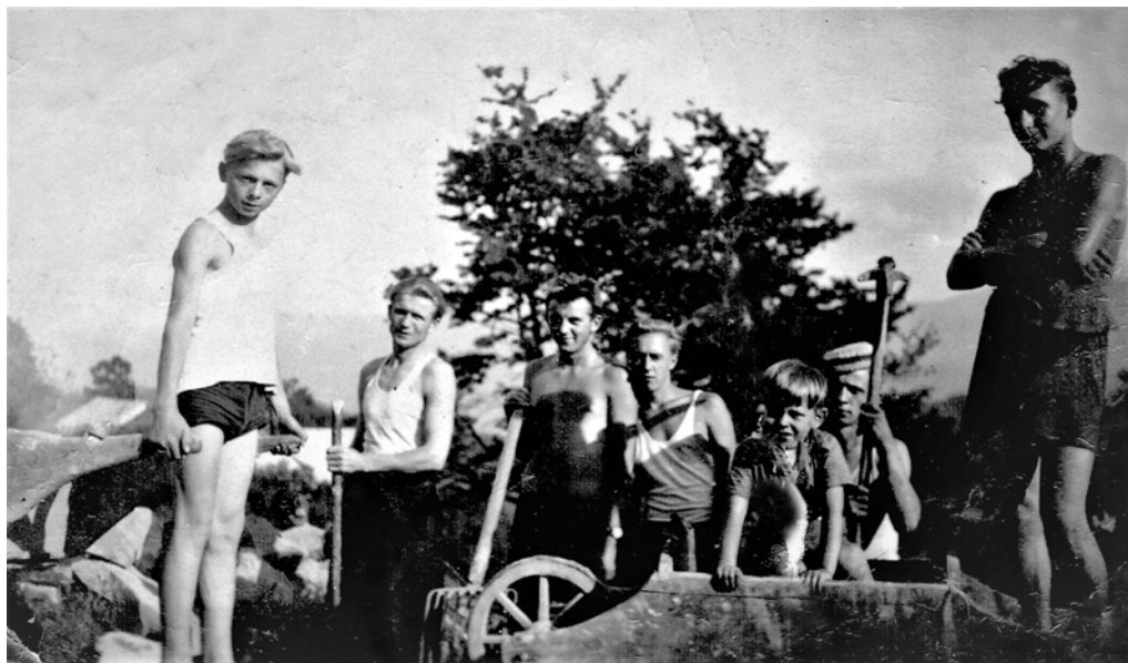
PRACA SPOŁECZNA PRZY BUDOWIE DROGI
